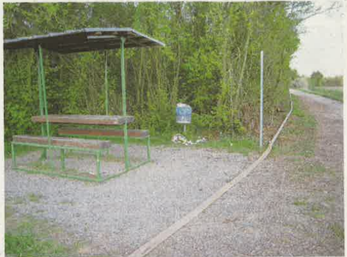
Leitung nördlich des Weges ...
