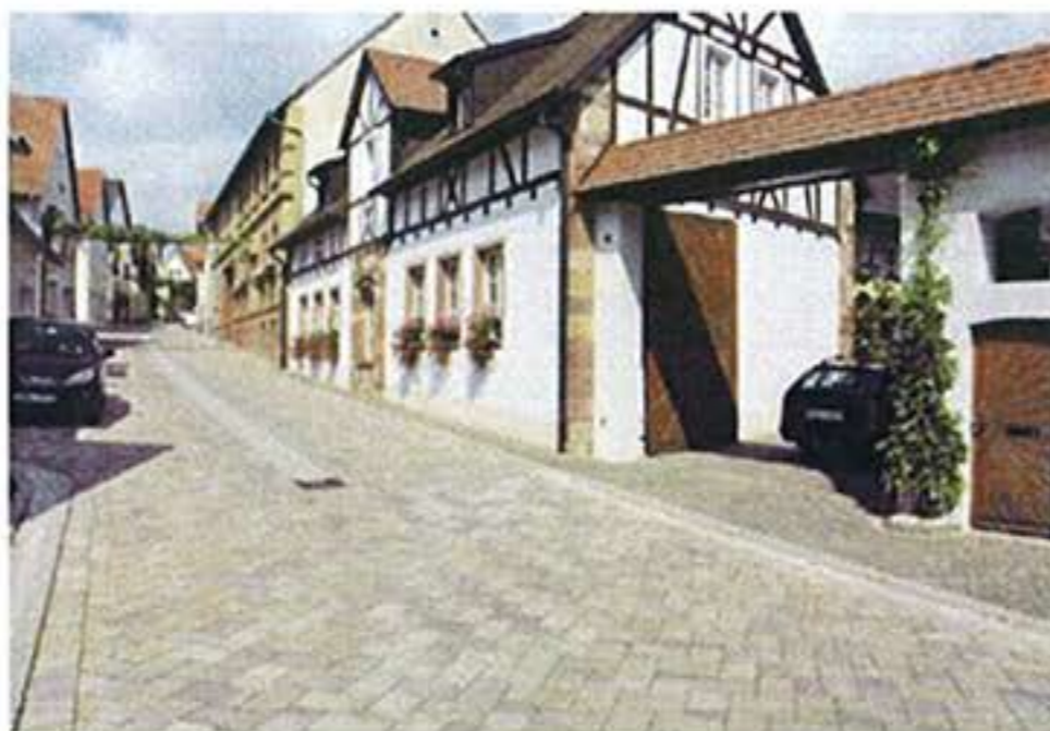
Nachher: Die Steine – verlegt im Ellenbogenverband – verbinden die attraktive Optik eines Gestaltungspflasters mit den Vorteilen eines Vollverbundsystems.
