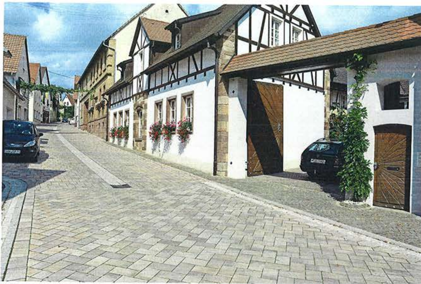
Die Steine – verlegt im Ellenbogenverband – verbinden die attraktive Optik eines Gestaltungspflasters mit den Vorteilen eines Vollverbundsystems.
